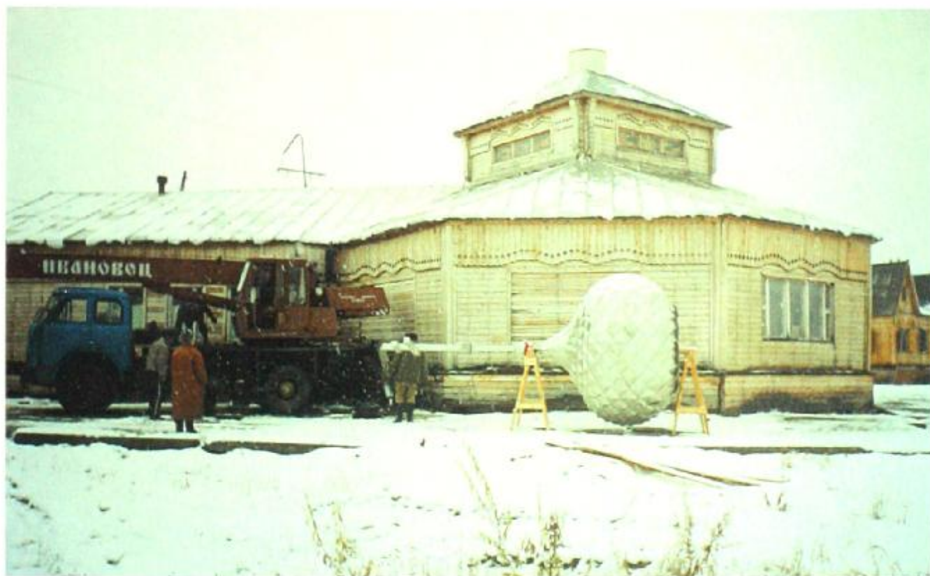
1996 г. Пос. Старый Уренгой. Строительство храма
